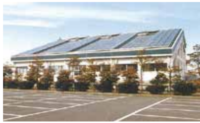
大村勤労者体育施設プール | 所在地 | 大村市 1979
