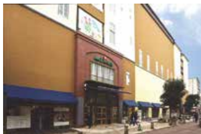
メルカつきまち (改修) | 所在地 | 長崎市 2018
