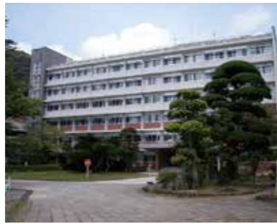
長崎大学経済学部本館 (改修) | 所在地 | 長崎市 2010
